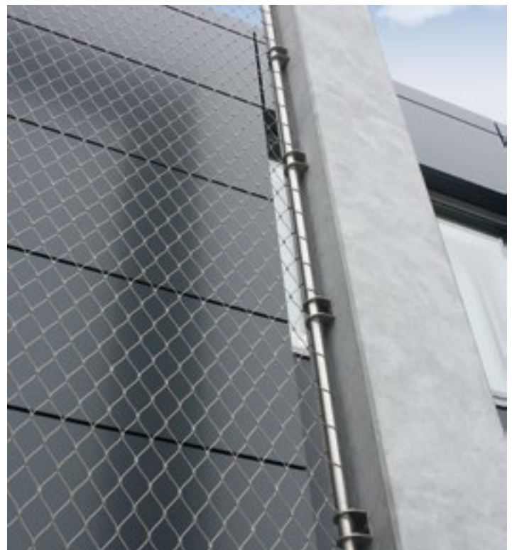
Stehende Masche_Vertical mesh diamond direction
